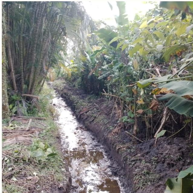
Limpeza e desobstrução das valas de drenagem, serviço realizado rotineiramente de modo a garantir que as águas pluviais percorram o curso previsto.
