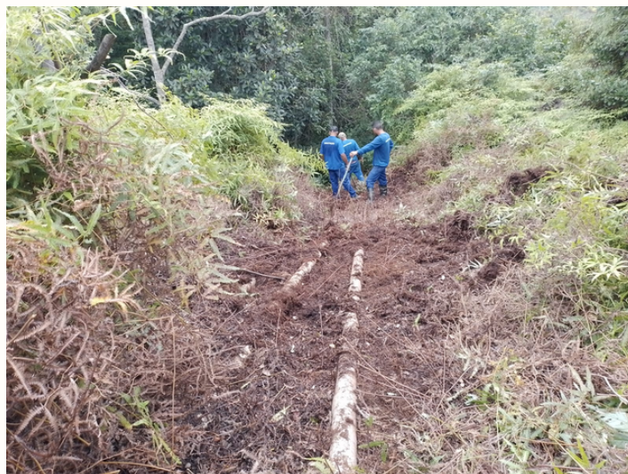
INSTALAÇÃO DE NOVA REDE ELÉTRICA, DA DISTRIBUIÇÃO DE ÁGUA
