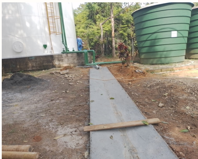
OBRAS - MELHORIAS NA E.T.A.
