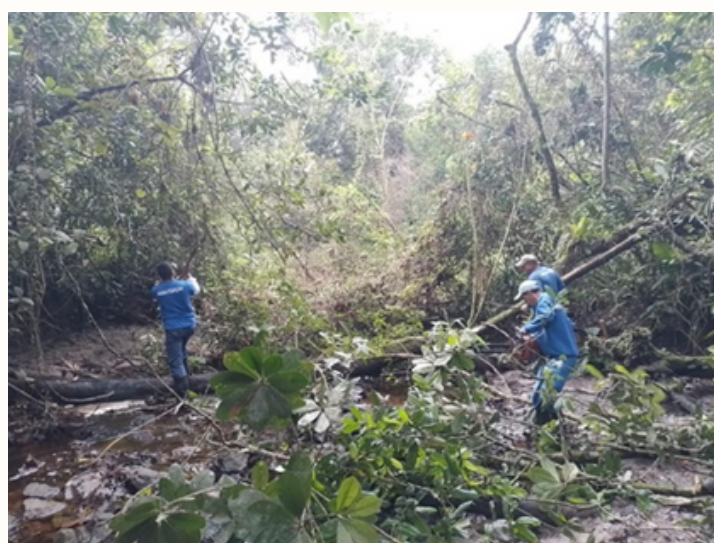
LIMPEZA DE VALA - SETOR Y
