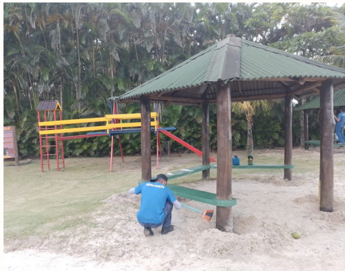
REFORMA DOS QUIOSQUES - PRAIA
