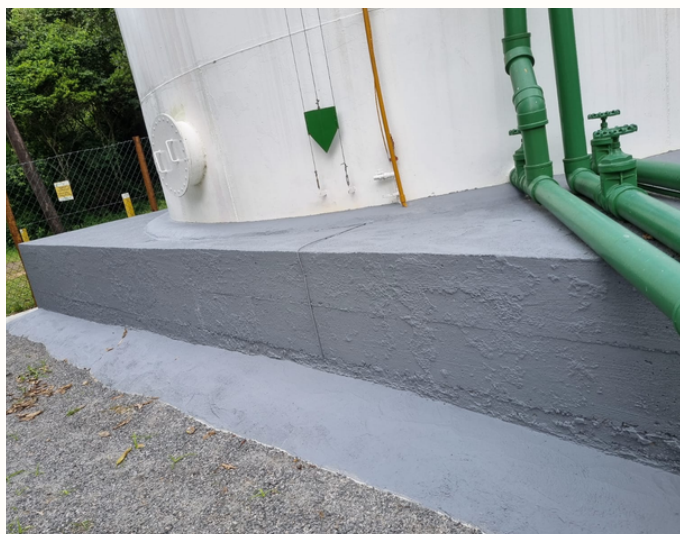
Manutenção da base de reservatório de água - E.T.A.
