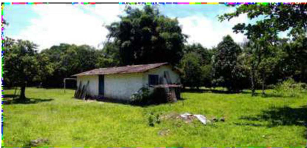
Foto 01: Frente da onstrução Casa Vermelha, a ser demolida (Fonte: FF)
