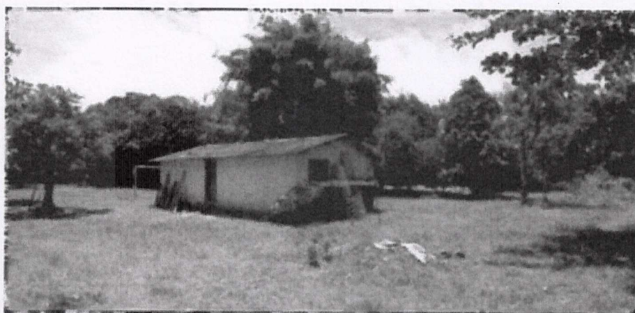
Foto 01: Frente da onstrução Casa Vermelha, a ser demolida (Fonte: FF)
