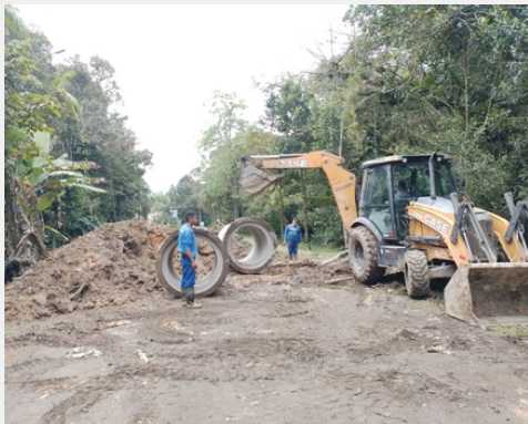
Instalação de manilhas de 1metro de diâmetro na Rua O 01
