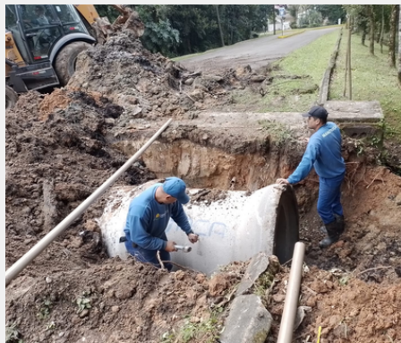
Instalação de manilhas de 1metro de diâmetro na Rua O 01
