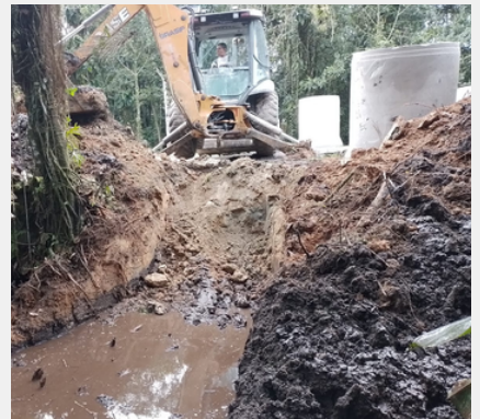
Instalação de manilhas de 1metro de diâmetro na Rua O 01
