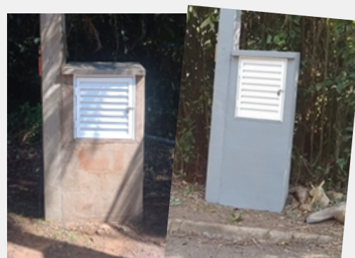
Abrigo de cameras-nobreak
