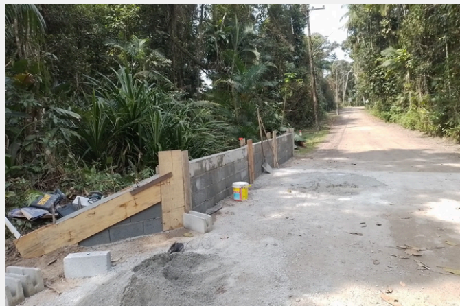
Construção de proteção viária na Marginal Y
