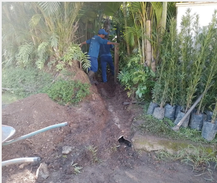
Instalação de manilha para escoamento de água pluvial - Quadra Xv
